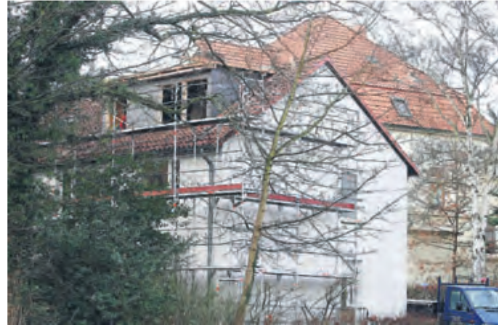
Das ehemalige Pfarrhaus am Aumunder Heerweg wird zu einem sogenannten Rückzugshaus für die ambulante Betreuung psychisch Erkrankter umgebaut. FOTO: CHRISTIAN KOSAK
